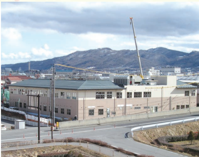
北西方向より見た新築建物
